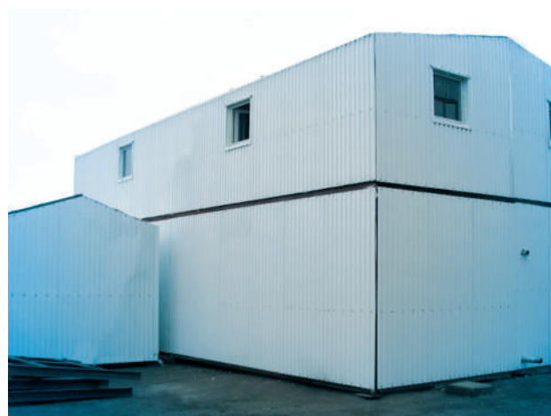
Изготовление, поставка и монтаж блочно-модульных очистных сооружений для аэропорта Шереметьево.
